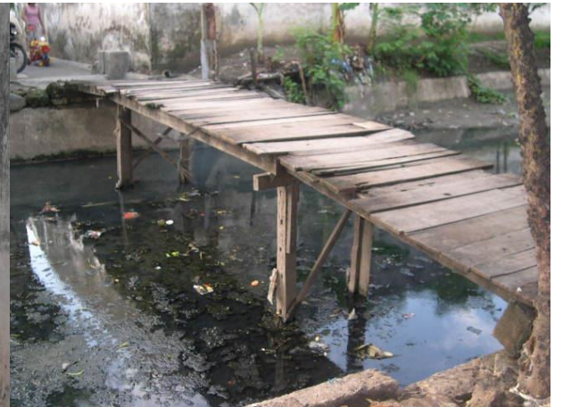
Perbaikan jembatan di kel Simomulyo
