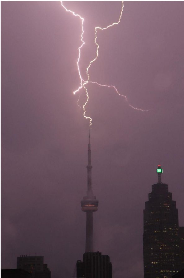
Gambar 1.59 Kilatan di ujung penangkal petir akibat penyatuan muatan dari udara sekitar penangkal petir dengan muatan di ujung penangkal petir di puncak CT Tower, Canada ( www.pinterest.com ).
