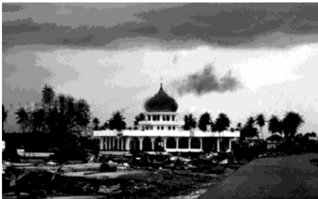
Gambar 1.7 Keadaan Lingkungan Akibat Gelombang Tsunami di Aceh
