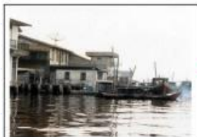
Bangunan di Atas Sungai Bangunan untuk fungsi permukiman maupun fungsi lainnya tidak hanya dibangun di darat maupun tepi sungai tetapi juga di tepian sungai. Pada beberapa kasus merupakan suatu yang cukup menarik, akan tetapi karena tidak adanya penataan mengakibatkan permukiman penduduk di atas sungai ini terkesan kumuh.
