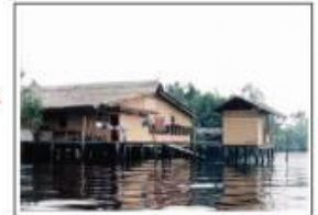
Bangunan di Atas Sungai Beberapa dari bangunan yang didirikan di atas sungai juga dilengkapi dengan berbagai fasilitas seperti kamar mandi, dimana air kotor disalurkan langsung ke sungai sekaligus air sungai dimanfaatkan sebagai sumber air bersih.
