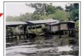
Bangunan di Atas Sungai Pada beberapa kasus, bangunan yang didirikan di atas sungai hanya merupakan bangunan sederhana yang berfungsi sebagai tempat pemberhentian sementara.
