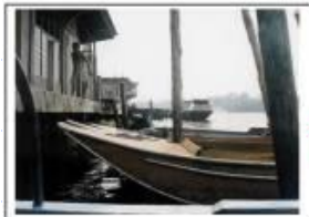
Bangunan di Atas Sungai Tidak hanya bangunan dari bahan kayu (tidak permanen dan semi permanen) yang dibangun di atas sungai, bahkan bangunan permanen (beton) juga dibangun di atas sungai.
