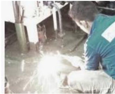
HOT WORK DAN COLD WORK PERMIT -
