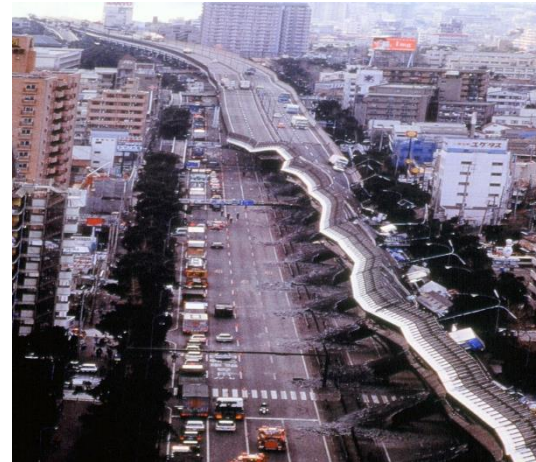
Gempa Kobe (Great Hanshin) , 17 Januari 1995 6.9 SR,
