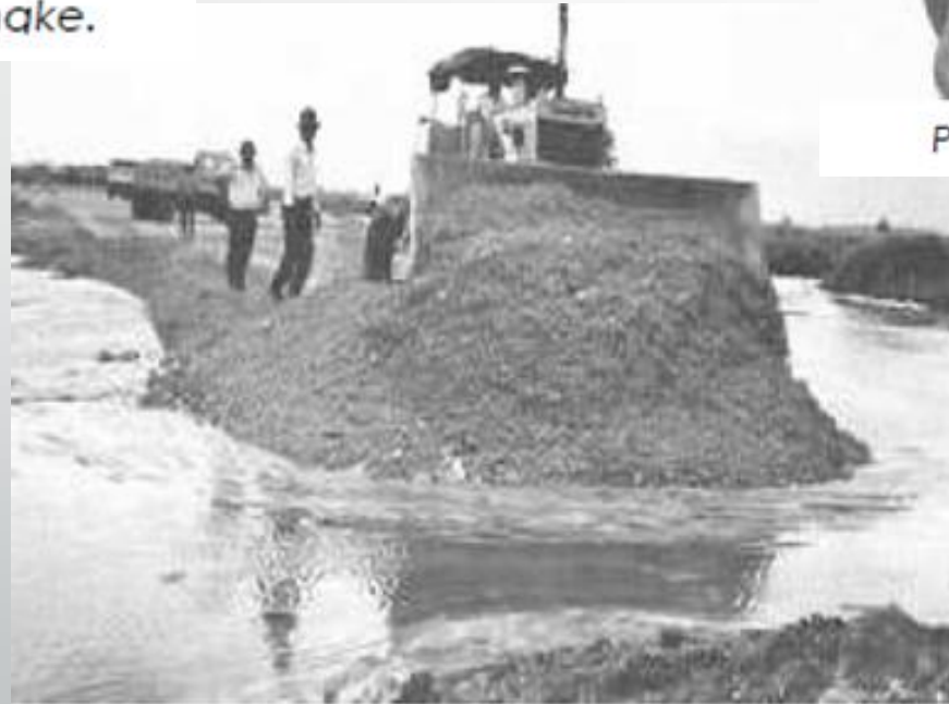
Penimbunan coral sand di atas geotextile.
