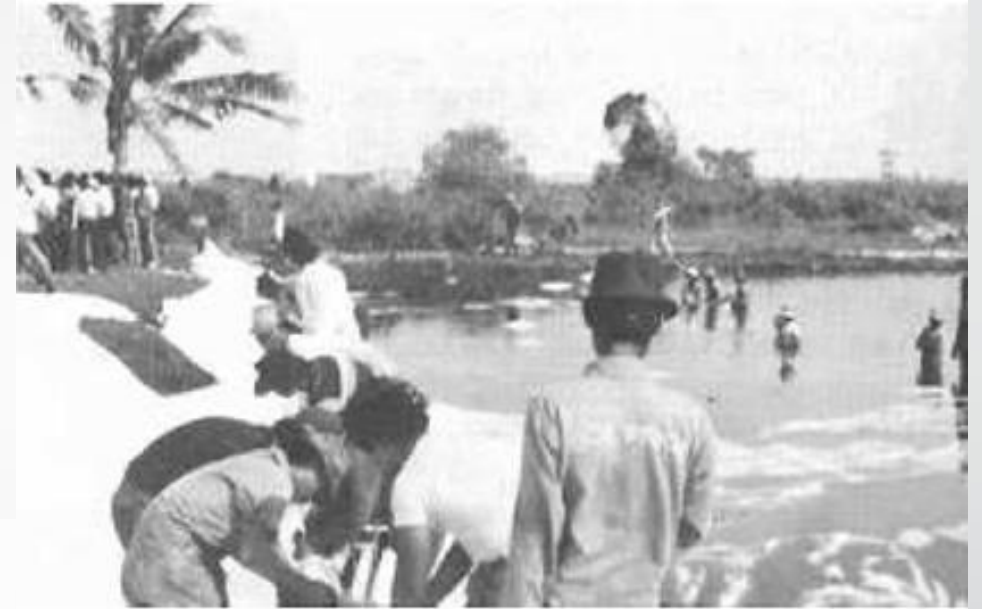
Penggelaran Geotextile di daerah yang telah
