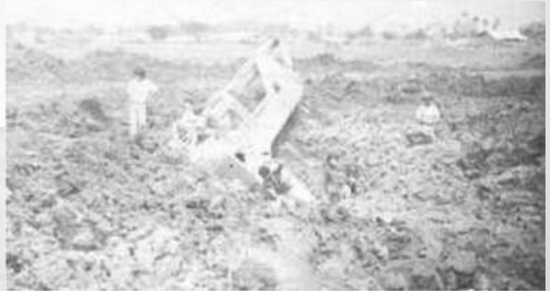
Beratnya medan yang berlumpur menyebabkan excavator yang digunakan untuk pengupasan terperosok di lumpur.
